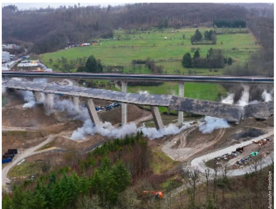
Bei der Sitzung des Verkehrsausschusses waren auch die Arbeiten an den hiesigen Autobahnbrücken (hier eine Aufnahme der Ende März erfolgten Sprengung der Talbrücke Eisern) auf der Agenda.
