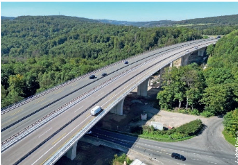
Der Neubau der Talbrücke Kalteiche hat den Bund etwa 60 Mio. € gekostet.
