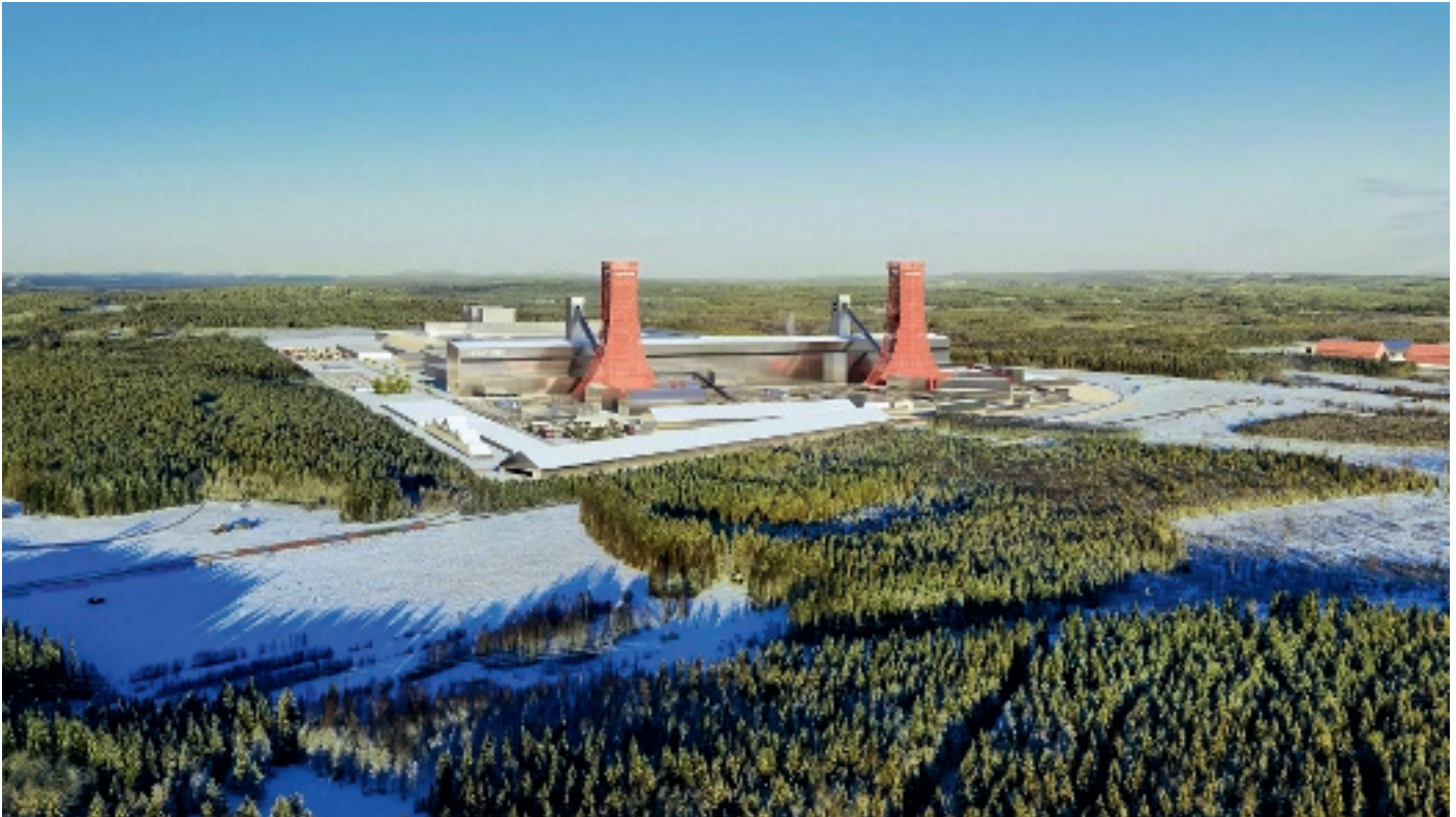
Zurzeit entsteht mit SMS-Technologie das Leuchtturmprojekt „H2 Green Steel“ in Schweden.
