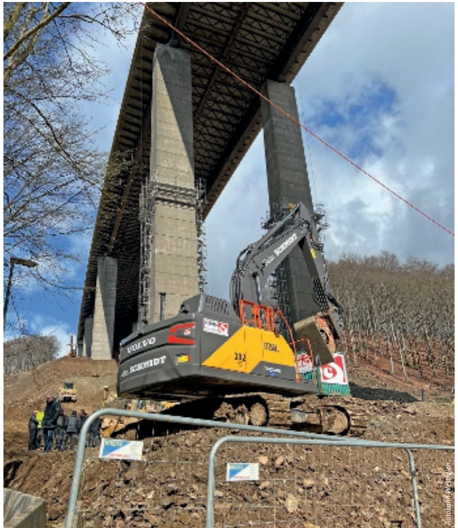
Die Talbrücke Rahmede soll am 7. Mai gesprengt werden.
