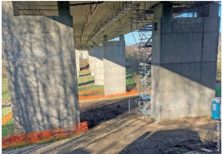
Die Talbrücke Saßmicke wird für insgesamt 4,4 Mio. € verstärkt.
