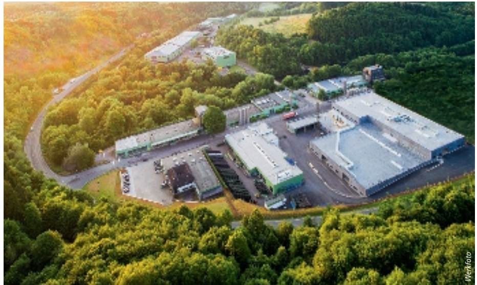
Am Firmensitz in Attendorn entstehen Rohrleitungssysteme „Made in Germany“.
