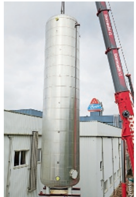
Als ein Teil des großen Investitionspaketes finden zwei neue Wassertanks ihren Platz am Metten-Produktionsgebäude.
