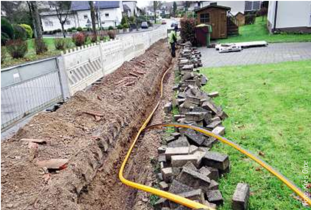
Verlegung von Glasfaserleitungen.
