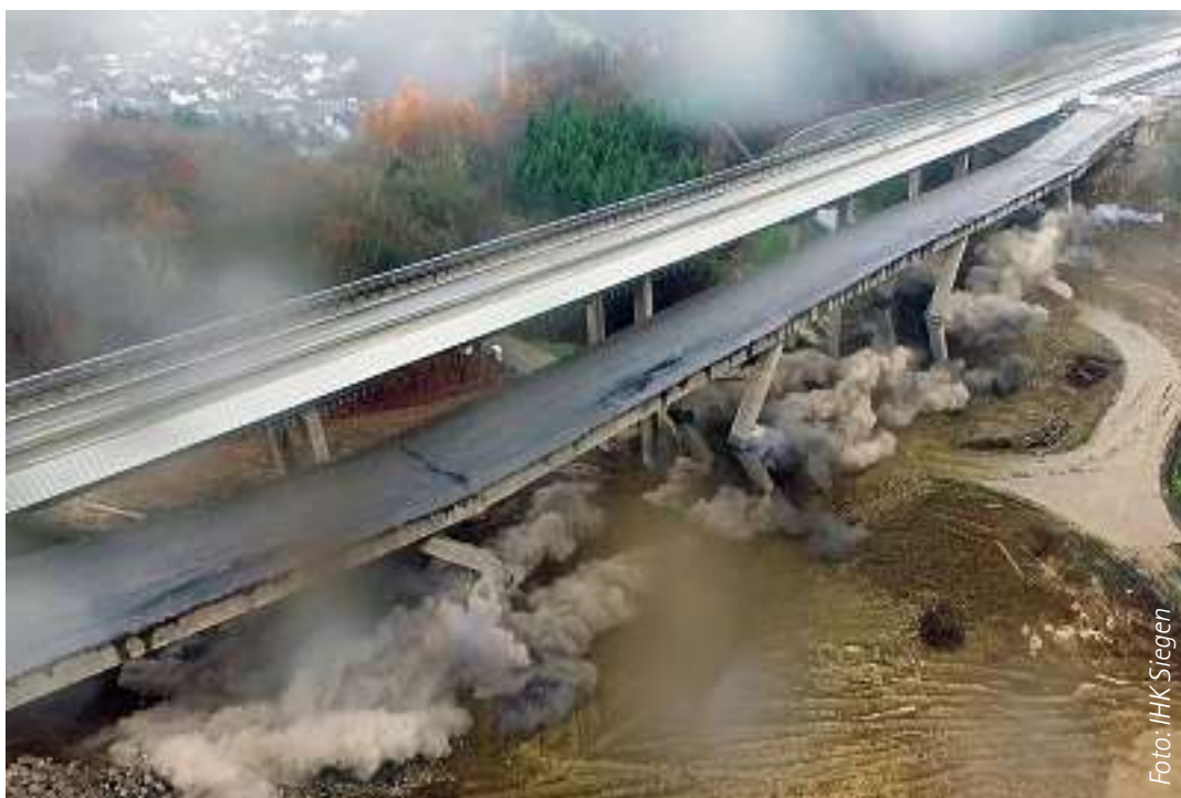
Sprengung der Talbrücke Rälsbach im Zuge der Erneuerungsarbeiten an der A45.
