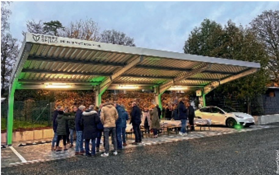
Die Pilotanlage der PowerShield GmbH ist fertig.
