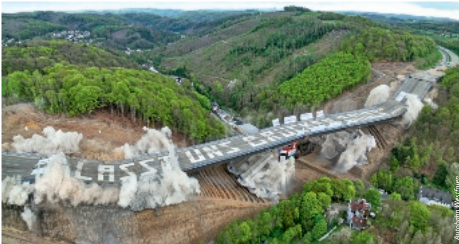
Die Talbrücke Rahmede wurde am 7. Mai gesprengt.
